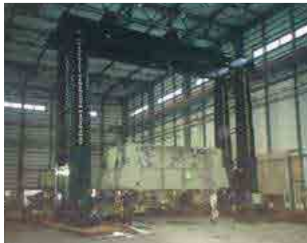
プレス機搬入・据付作業 (TB-1000)
