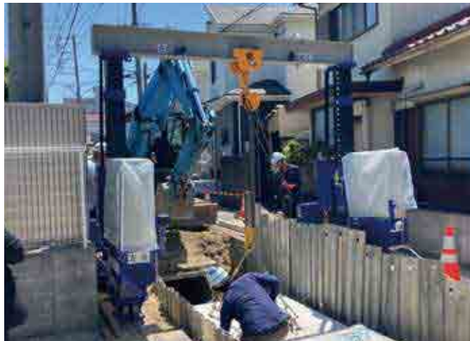
ボックスカルバート設置作業 (TB-50)
