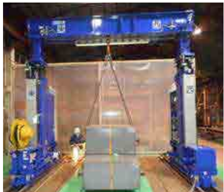
倉庫内 揚重作業 (TB-150)
