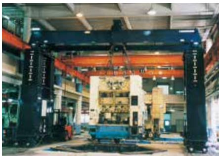
プレス機搬入・据付作業 (TB-1000)
