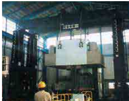
プレス機搬入・据付作業 (TB-2000)
