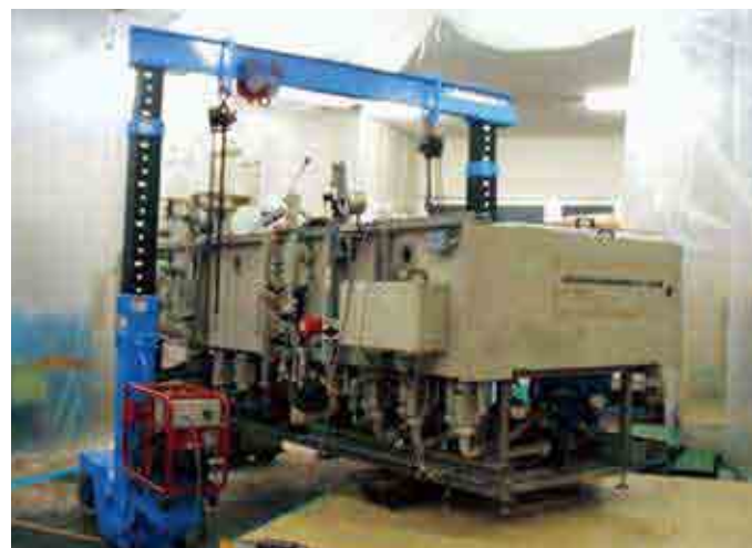
装置組立・据付作業 (TB-30)
