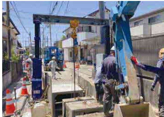
ボックスカルバート設置作業 (TB-50)
