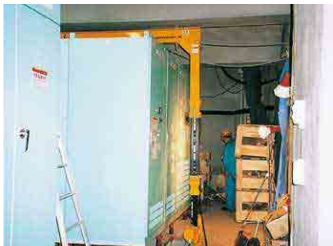
制御盤設置作業 (TB-20)
