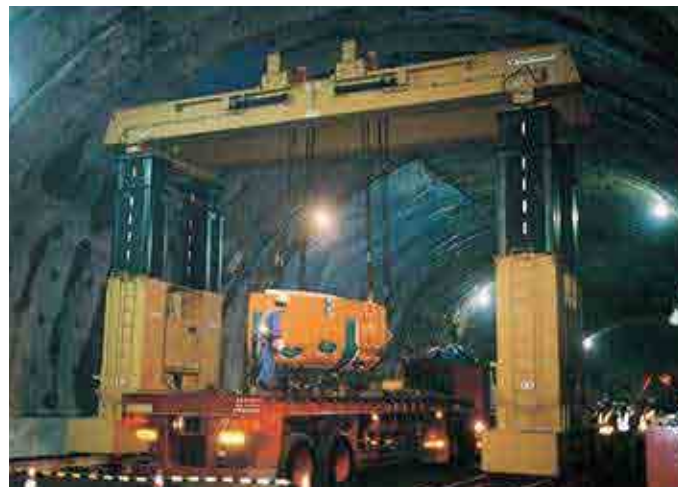
トンネル内工事現場 TBM組立作業 (TB-1000)
