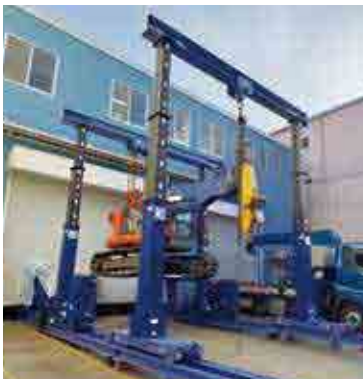
建屋外 装置搬入作業 (TB-100 × 2)
