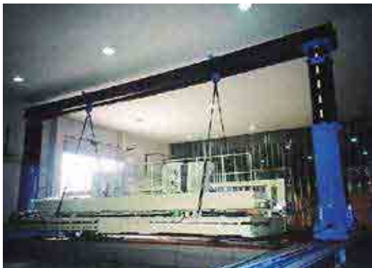
倉庫内 揚重作業 (TB-300)
